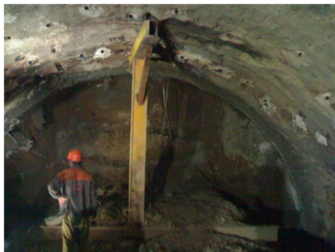
شکل ۹- اولین مرحله خاک برداری بخش ریزش کرده تونل قطعه A4-B4
