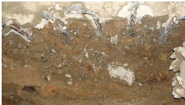
شکل ۱۱- نمایی از لوله های تزریق و رسیدن حباب های تزریق گمانه ها به همدیگر در تونل T3-U3
