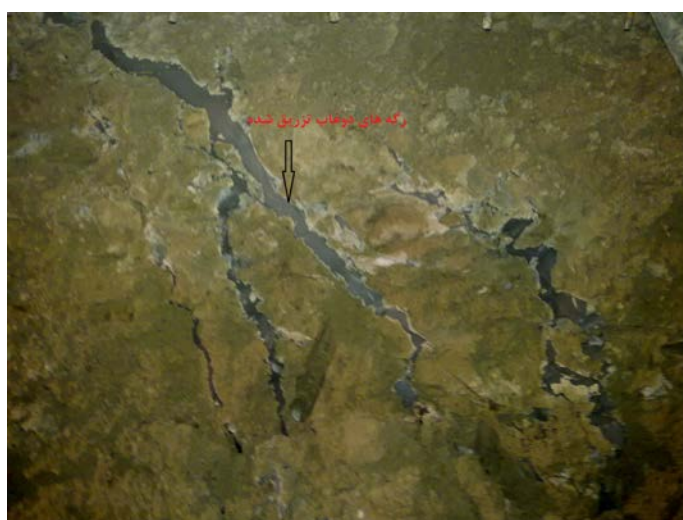
شکل ۱۲- نمایی از رگه های دوغاب تزریق شده در حین تزریق لوله های تزریق طاق چتری ایستگاه N3
