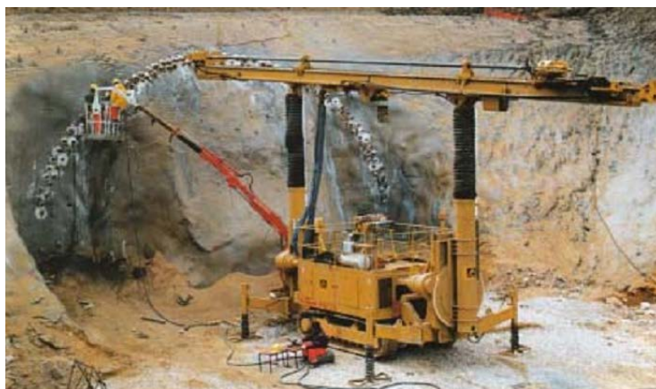
شکل ۱- انجام عملیات حفاری و تزریق طاق چتری در ورودی تونل
