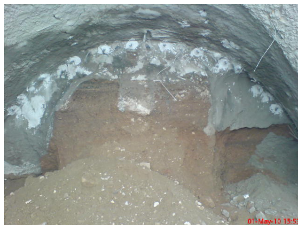
شکل ۷- اجرای تزریق طاق چتری در تونل دسترسی به تونل قطعه T3-U3
