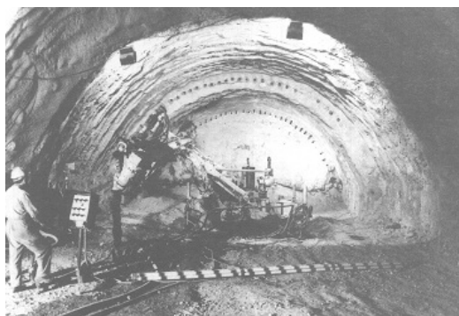
شکل ۲- الگوی گمانه ها و هم پوشانی مراحل مختلف تزریق طاق چتری
